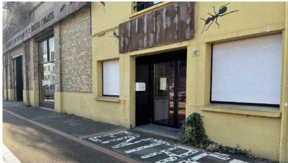
La façade du 60 rue du Fort-Louis a été déshabillée de l'enseigne de la Licorne, en attendant de retrouver un nouveau décor.
